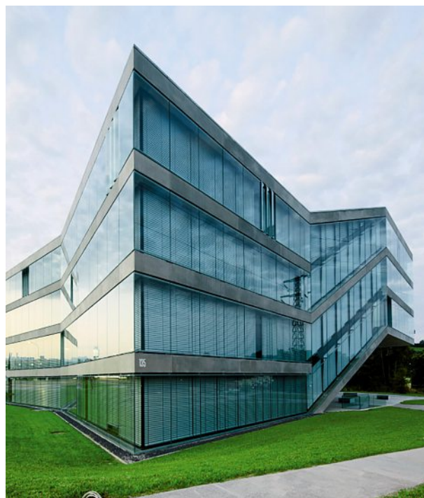
Administrationsgebäude Groupe E SA in Granges-Paccot; Quelle: WICONA Schweiz
