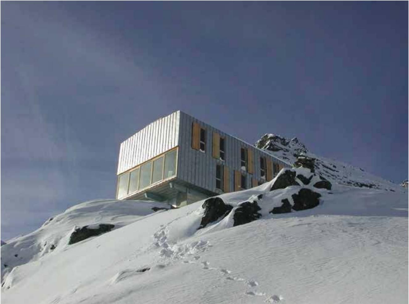
**Bild 5:** Die beidseitig mustergewalzte Oberflächenausführung der nichtrostenden Fassadenbekleidung der von Meier Associés Architectes S.A. realisierten Schutzhütte Topali des Alpenvereins Matteredal, St. Niklaus, schimmert reflexionsarm im Sonnenlicht (Foto: Aperam Stainless Services & Solutions Germany GmbH, Erkrath)
